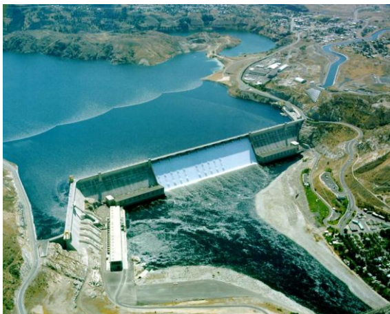
图 1 – 位于华盛顿州哥伦比亚河上的大古力水坝，美国：装机容量 6809 MW。第三电站：3x605 MW 和 3x805 MW
